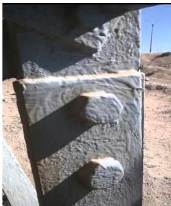
Si-Coat 579, 5 ans après son application. Aucune altération ni dégradation malgré les dépôts de sables et de salinité.
